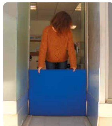
Installation d'un batardeau
